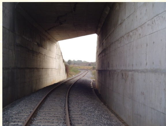
Passagem Inferior Linha de Carga
