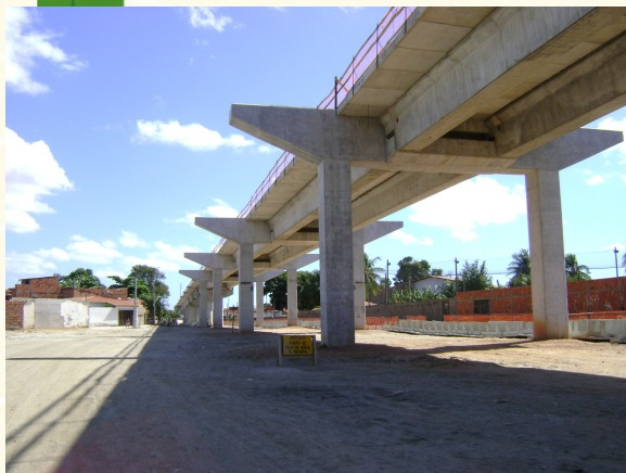
Trecho em Elevado
