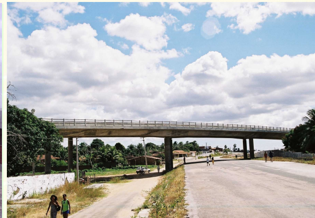
Viaduto Rodoviário da Rua Oriente
